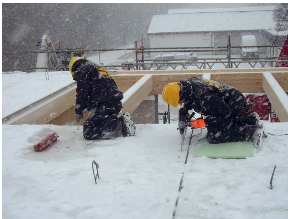
Montage einer Fertigteilplatte mit FT-Verbindern auch bei winterlichen Verhältnissen
