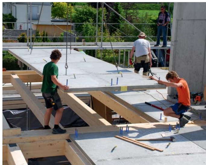
Verlegen/Montieren einer Fertigteilplatte mit FT-Verbindern auf Balkenlage (hier inkl. integrierter Massenaktivierung für Heiz- und Kühltechnik)
